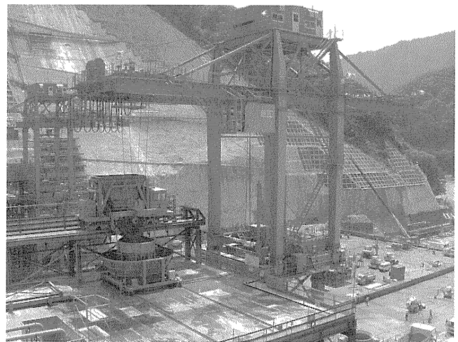
写真—4 自動運転によるコンクリート運搬状況
