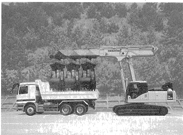
写真-5 ダンプトラック積み込み状況
