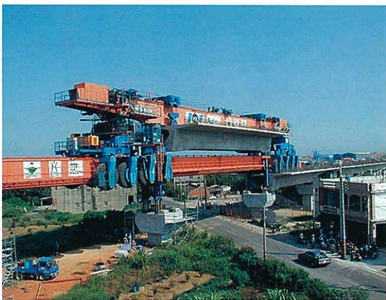
↑ プレキャスト桁を積載したラウチングキャリアが現場に到着し、後方駆動部にてサポートビーム上に押し出された状態
