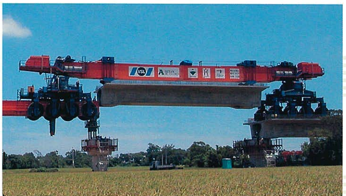
↑↓ サポートビームが前方に押し出され、ラウチングキャリアで運ばれてきたプレキャスト桁が降ろされる
