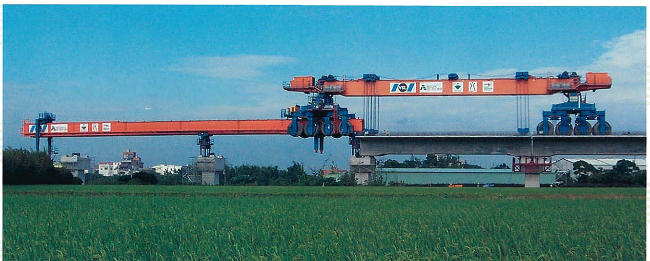
↑ プレキャスト桁の据付終了
