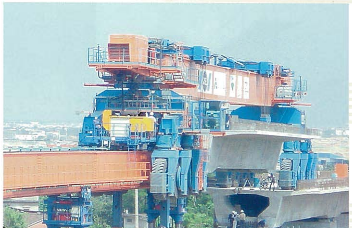
↑↓ サポートビームが前方に押し出され、ラウチングキャリアで運ばれてきたプレキャスト桁が降ろされる
