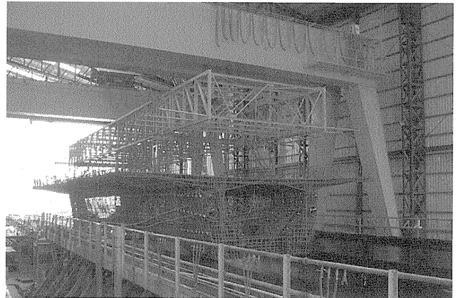
写真—4 プレハブ鉄筋吊込み
