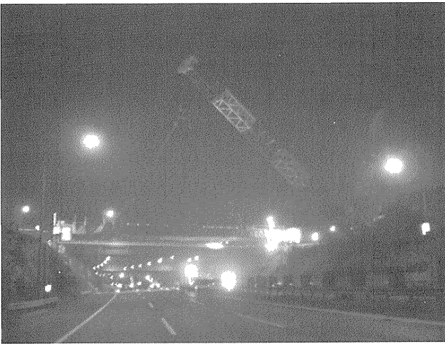
写真-2 1,200 t クレーンによる道路橋吊上げ
