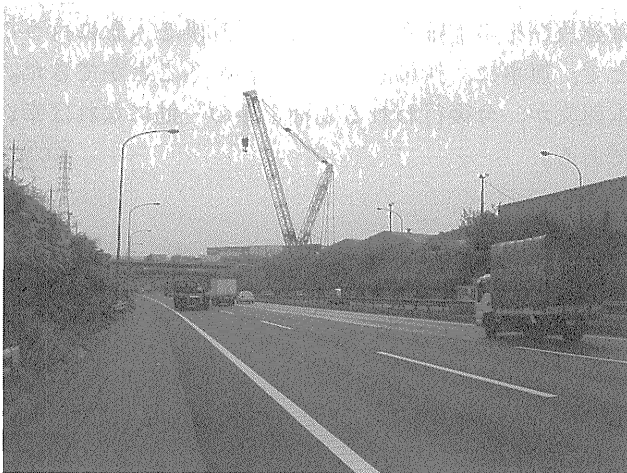
写真-1 高速道路より見た1,200tクレーン（施工前）
