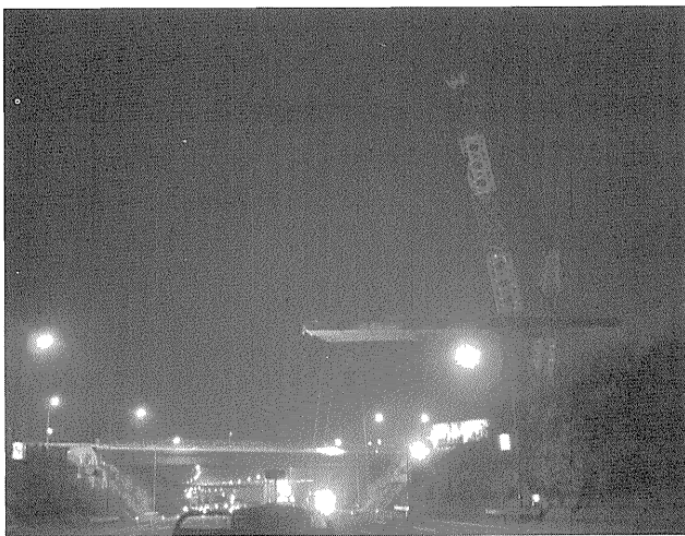
写真-3 1,200 t クレーン旋回状況
