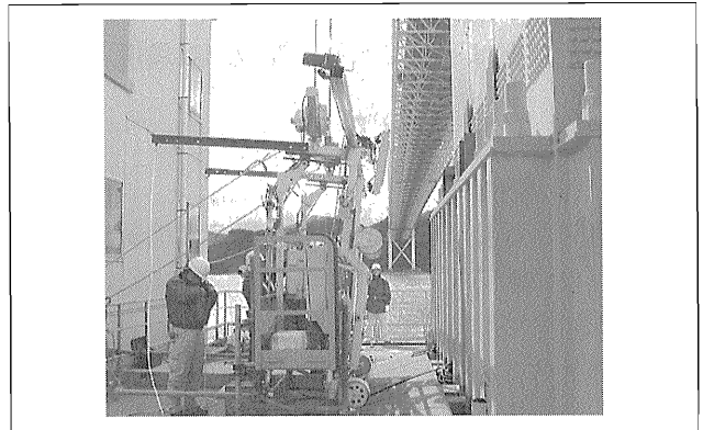
写真—3 塗装装置と磁石車輪ゴンドラ
