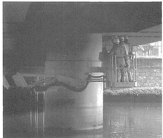
写真-3 橋脚下作業
