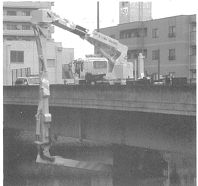
写真-2 橋脚下作業
