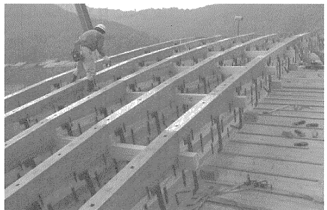
写真-3 第4橋 後詰め、巻金、かすがいが取付けられた状況
