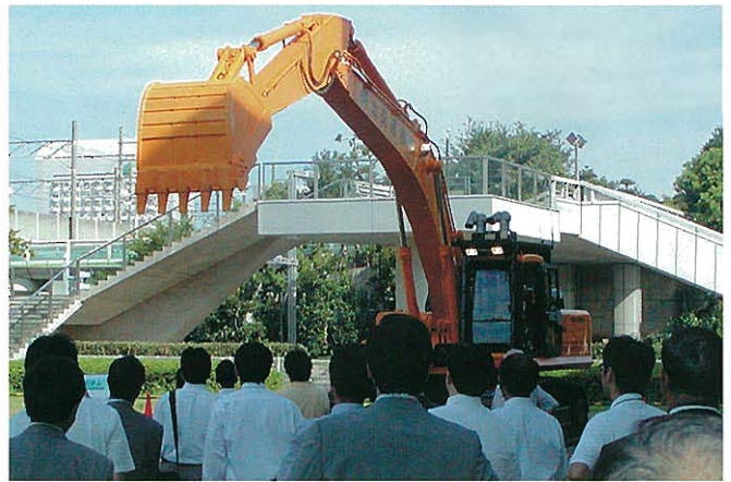
⇩遠隔制御で運転するバックホウ
