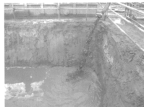
写真-8 貯泥状況
