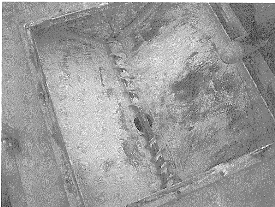
写真-1 標準固化材供給装置 (固化材ホップ)
