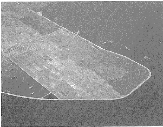
写真-3 導入現場の全景
