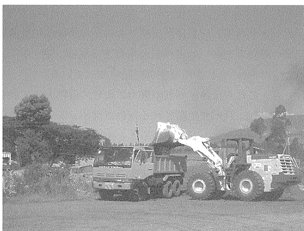
写真—3 仮設道路工事
