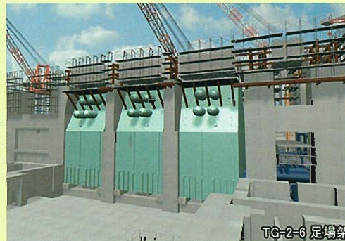
↑③オペレーティングフロア無支保工梁の設置
