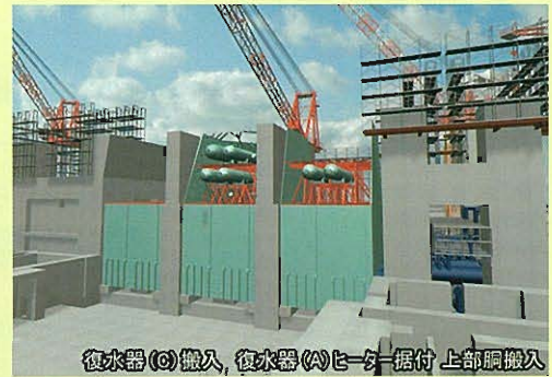
↑②ヒーター据付
