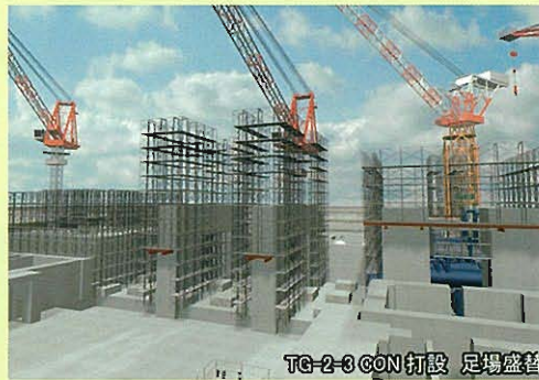
↑①タービン架台2層目躯体構築
