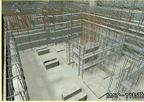
↑①壁躯体工事用足場架設,B2F壁躯体工事
