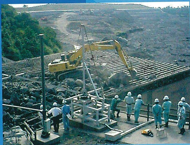
桜島(野尻川)のスクリーンダムに 堆積した巨石の除去作業状況
