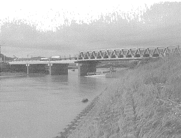
写真一六 応急組立橋架設状況
