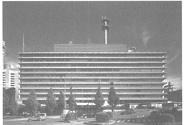
写真—1 中央合同庁舎3号館（外観）
