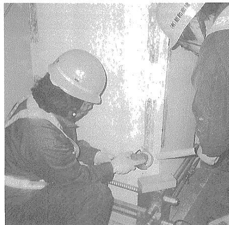
写真-3 柱表面の清掃状況
