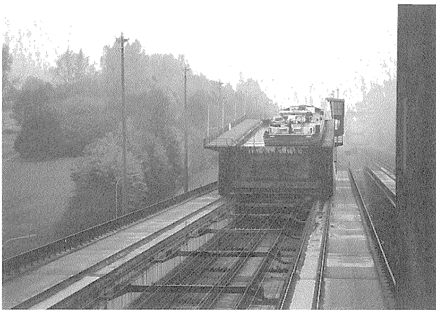
写真—1 ロンキエール・インクライン
