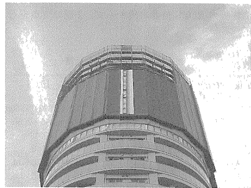
写真-1 スカイクライマー設置状況
