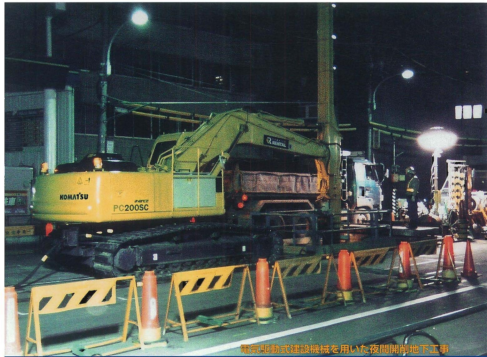
電気駆動式建設機械を用いた夜間開削地下工事
