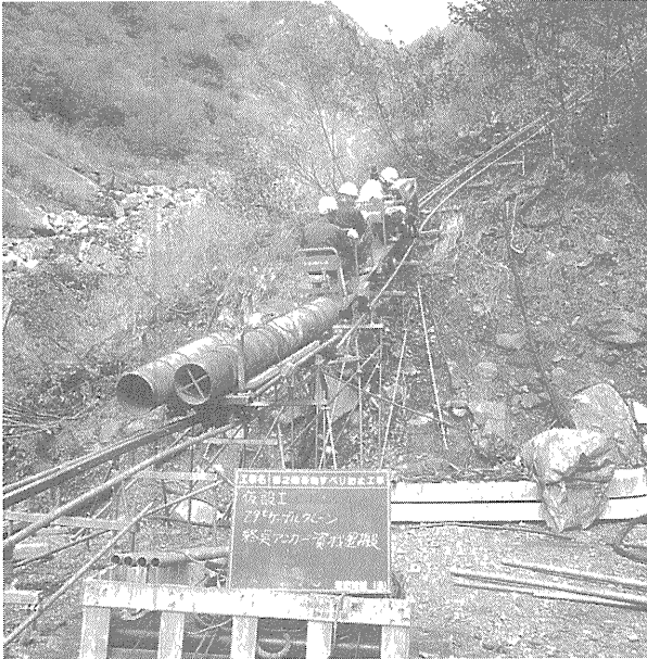
写真-4 モノレール運搬状況
