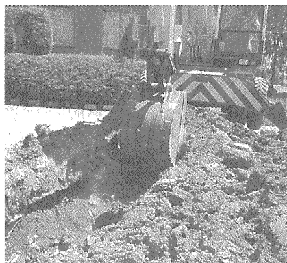
写真-6 建設機械による掘削
