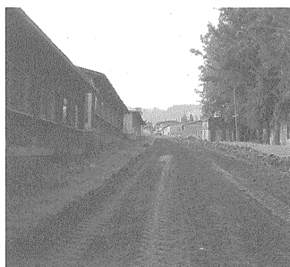
写真-7 グレーダ作業終了
