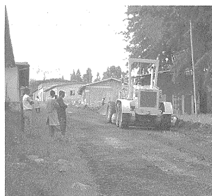
写真-5 グレーダ作業
