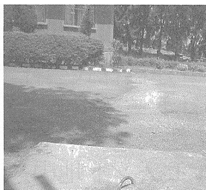
写真-4 側溝工事前
