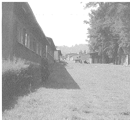
写真-3 仮設道路建設前
