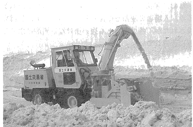
写真-3 幅員可変型小型除雪車の実演状況
