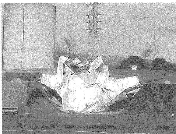
写真2 試験発破直後の状況
