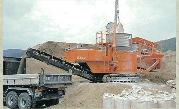
⇩最終処分場におけるベントナイト混合土の製造
