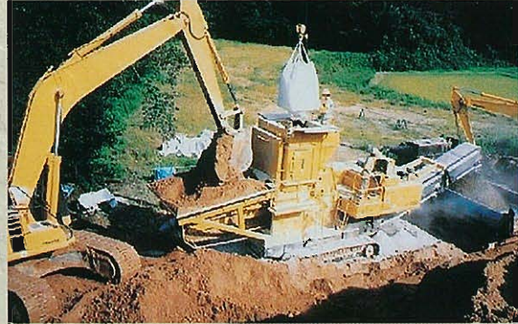
⇩最終処分場建設現場でベントナイトによる改質作業中
