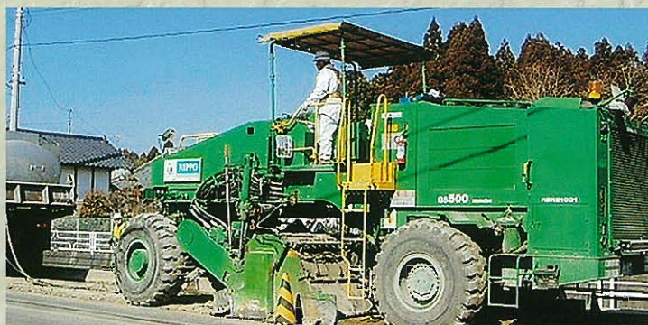
⇩ロードリサイクラによるセメント・アスファルト乳剤混合作業中
