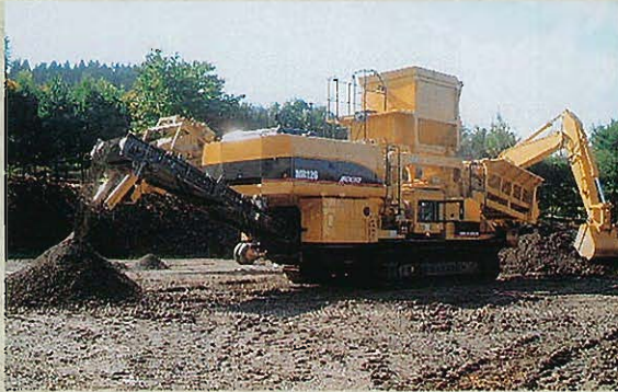
⇩関東ローンを生石灰により改質作業中
