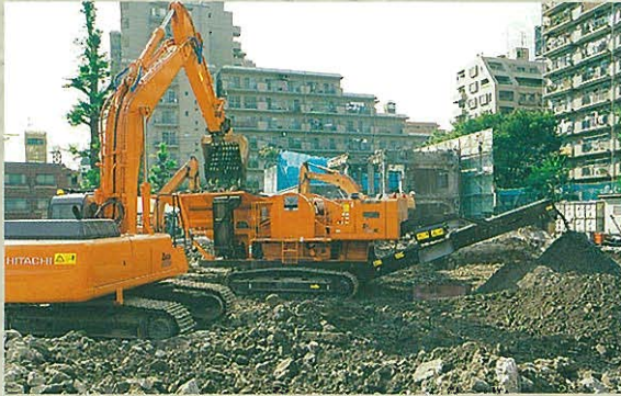
⇩コンクリートガラを破碎、現場内にリサイクル材として再利用
