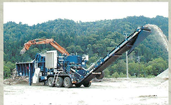
⇩林道工事発生木材をヤードにて粉碎作業中
