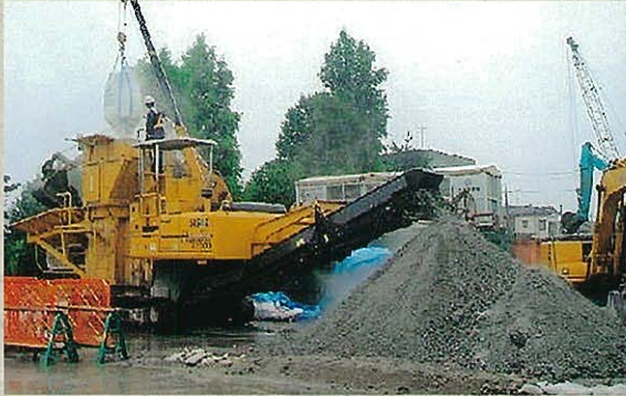
⇩建設汚泥を生石灰により改質作業中
