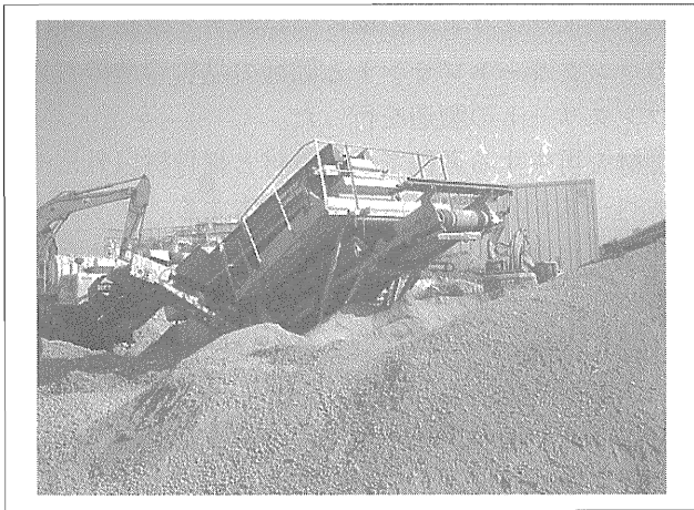
写真-6 コンクリート塊の処理
