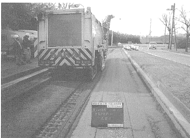
写真二 大型路面切削機による予備破碎状況
