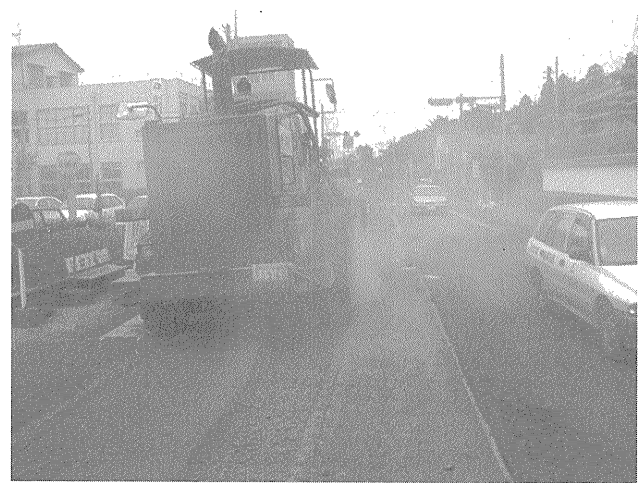
写真三 ロードスタビライザによる固結路盤の破碎状況
