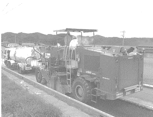
写真-6 セメント・フォームドアスファルト混合状況
