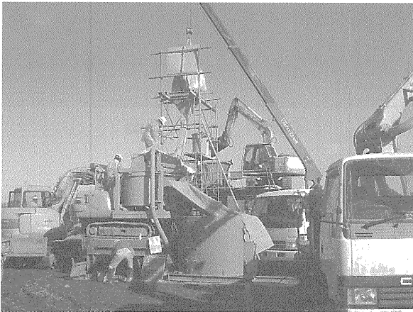
写真—5 混練作業
