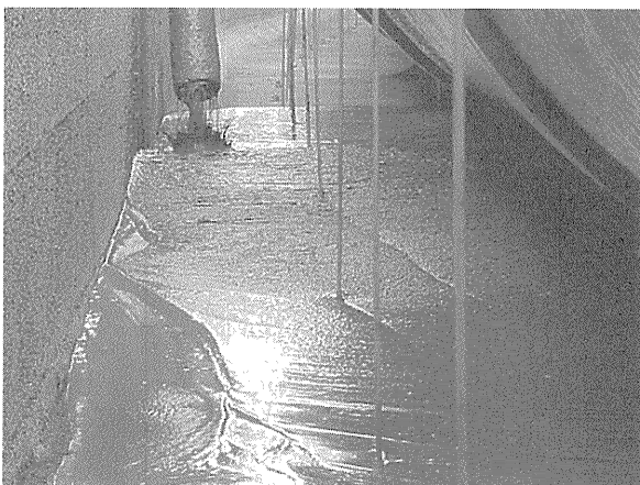
写真—7 打設状況
