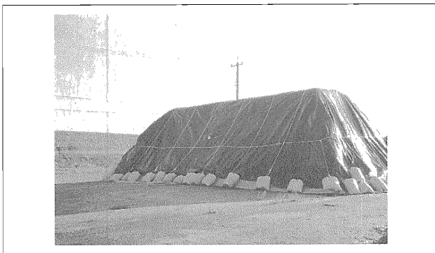
写真—3 シート掛け状況
