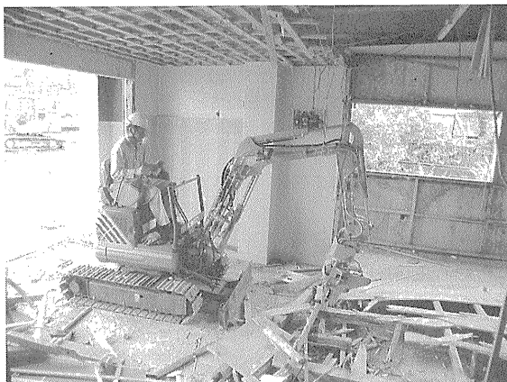
図-14 内装解体機 (コベルコ建機 SK 13 R)
