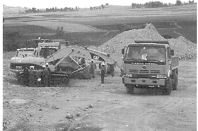
写真-4 現場での実習状況
