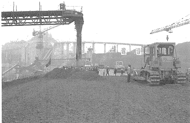
写真-1 タワーベルトコンベヤによる打設状況
