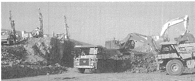
写真—2 洪水吐岩掘削状況
