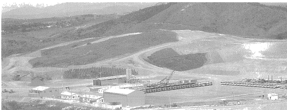
写真-4 プラントヤード (左) とモータプール (右)
