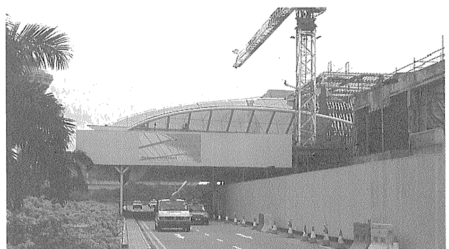
写真-6 キャノピー部全景 (トラベリング前)
