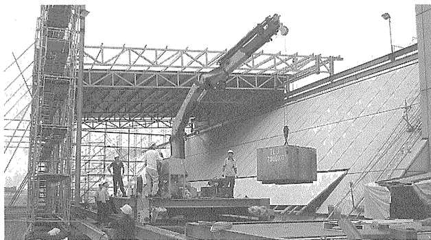
写真-14 走行式ミニクレーン (作業半径 12m 定格荷重 1.33t)
