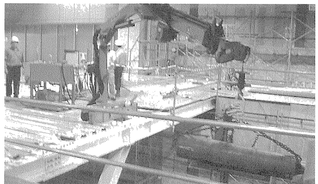
写真-11 ミニクレーン (作業半径7.5m, 定格荷重0.72t)
