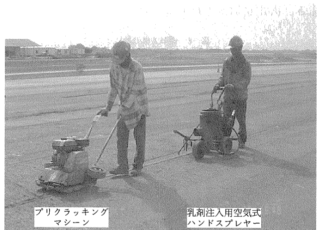
写真—6 クラック誘発目地施工状況
