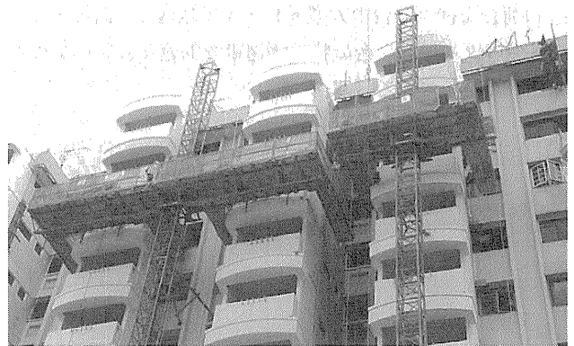
写真-12 機械式昇降足場
