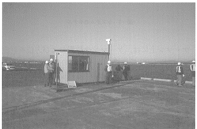
写真—5 遠隔監視・操作室
