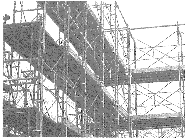
写真-1 手すり先行足場の施工例
