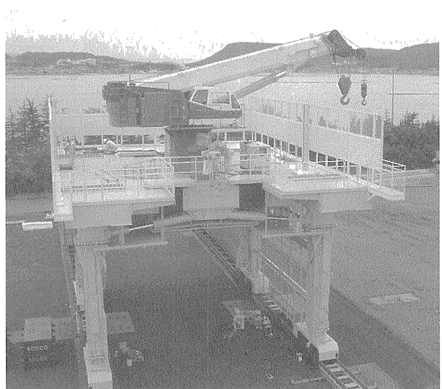
写真-2 移動式直接高架施工機
