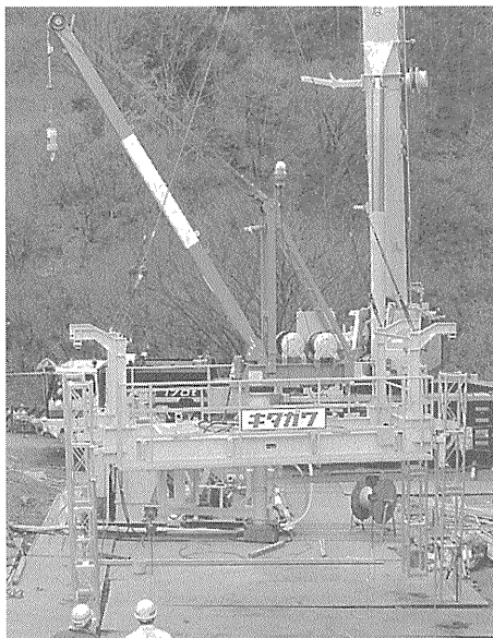
写真-1 自昇降式小型クレーン
