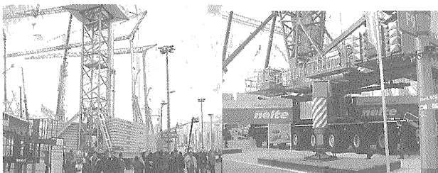
写真-42 クレーンと重し
