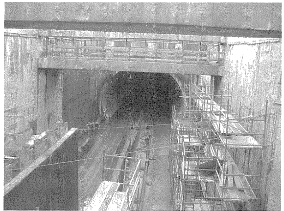
写真—52 トンネル部入口工事状況
