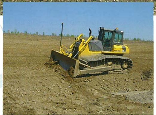
⇨法面整地状況
