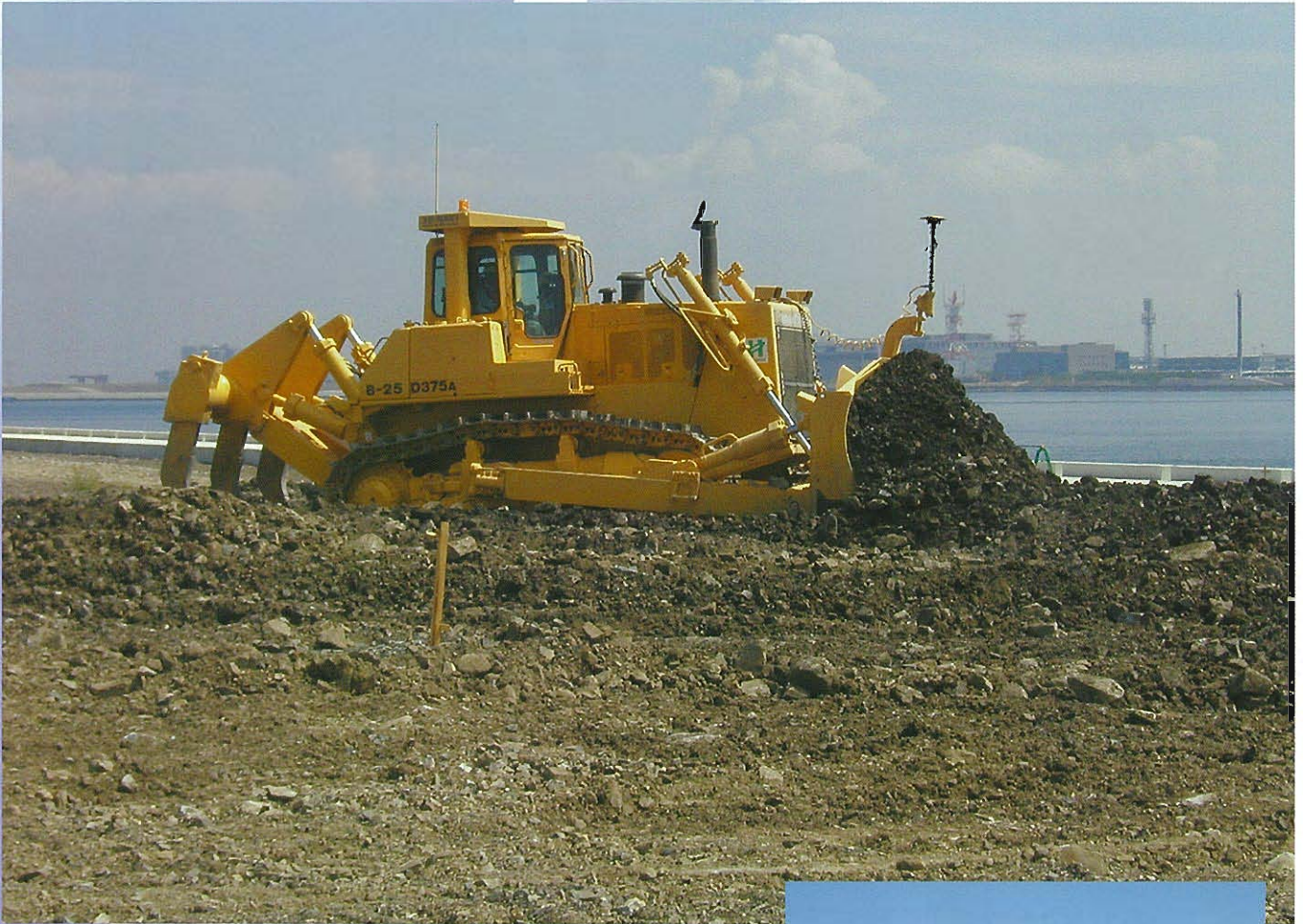
⇨路床転圧状況
