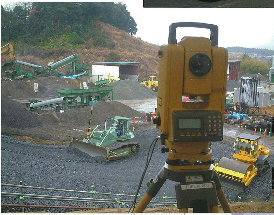
⇨ 3D-MCブルドーザによる法面作業(2割5分勾配)、手前は自動追尾トータルステーション(九州電力小丸川上部ダム工事試験施工)
