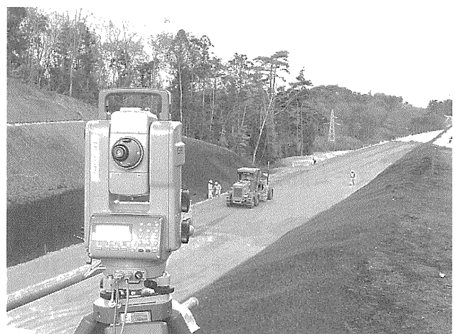
写真-3 3D-MC グレーダ施工状況
