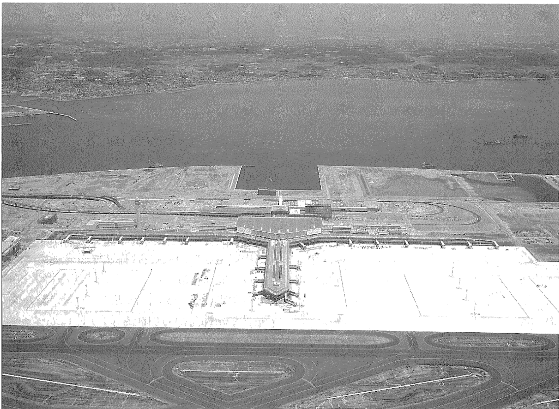
写真一1 セントレアの建設状況（2004年6月）；セントレア（CENTRAIR）は中部を表す Central と空港や航空を表す Air の合成語
