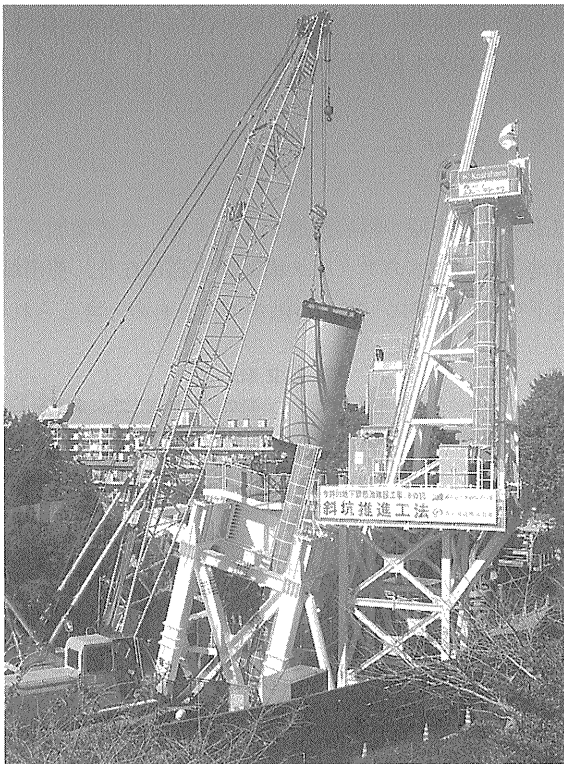
写真一 施工状況（推進管据付け）
