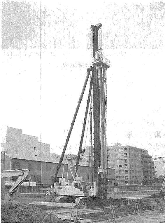
写真-1 パベット工法機全景
