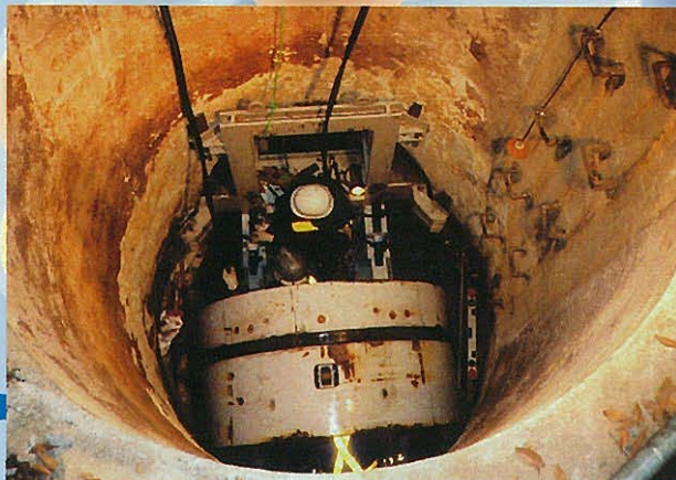
⇐反力装置・昇降用ガイドレール設置完了状況 ⇐先行装置設置状況
