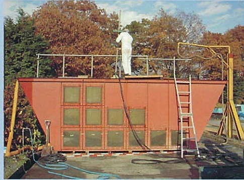
↓堆砂除去作業状況
