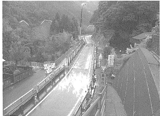
④ 復旧完了：開通
