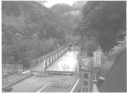
③ 応急橋設置完了
