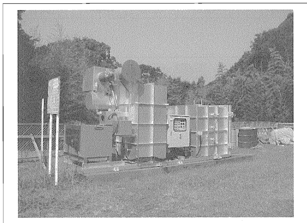
写真—6 炭化物製造装置設置状況
