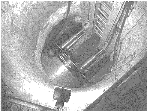
写真-6 推進状況 (ボックス RC 管)
