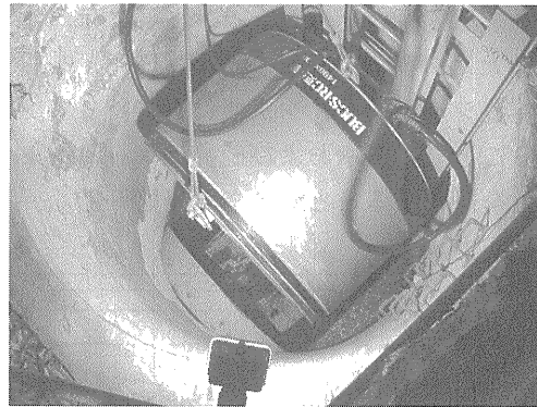
写真-5 推進装置・更生管吊降状況
