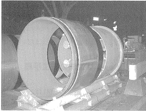
写真-4 推進装置・更生管一体化前状況
