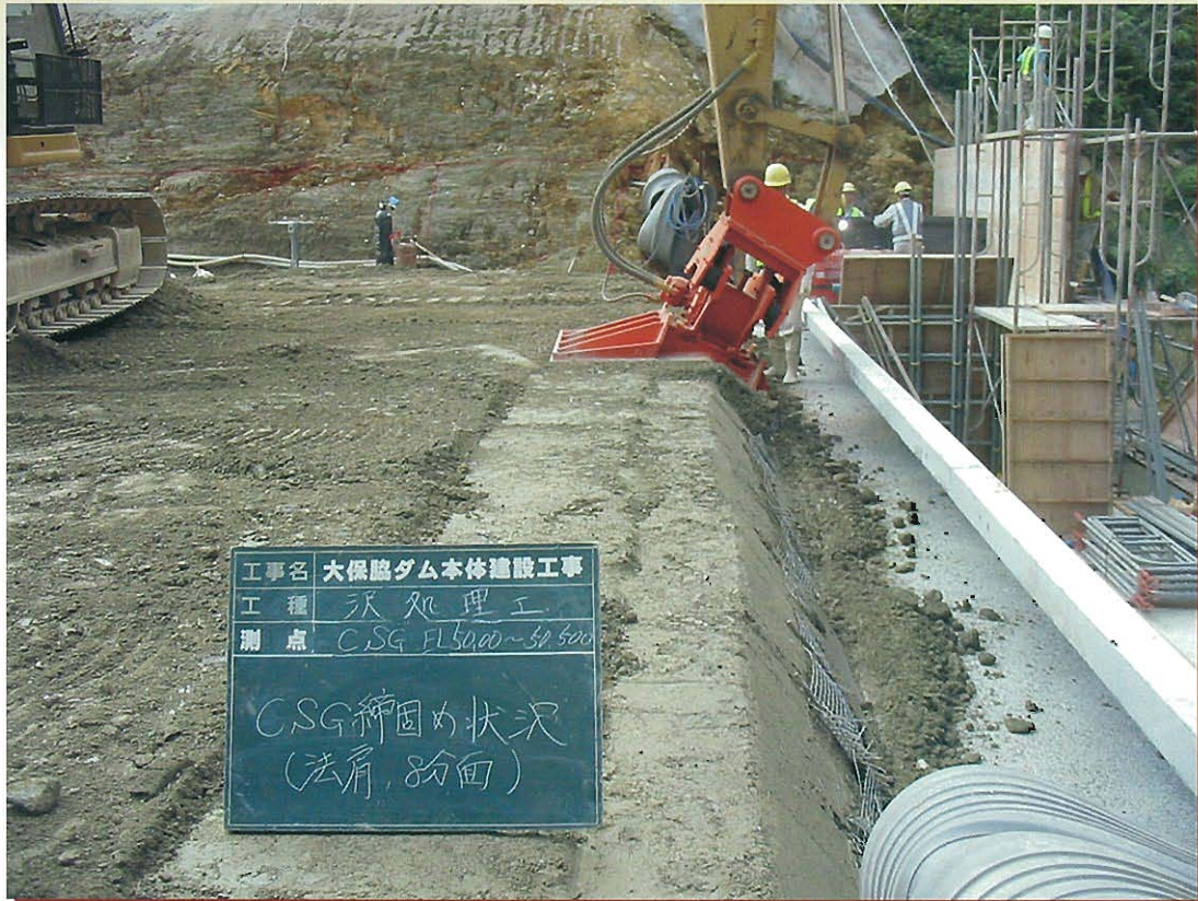
⇩ 法肩締固め状況
